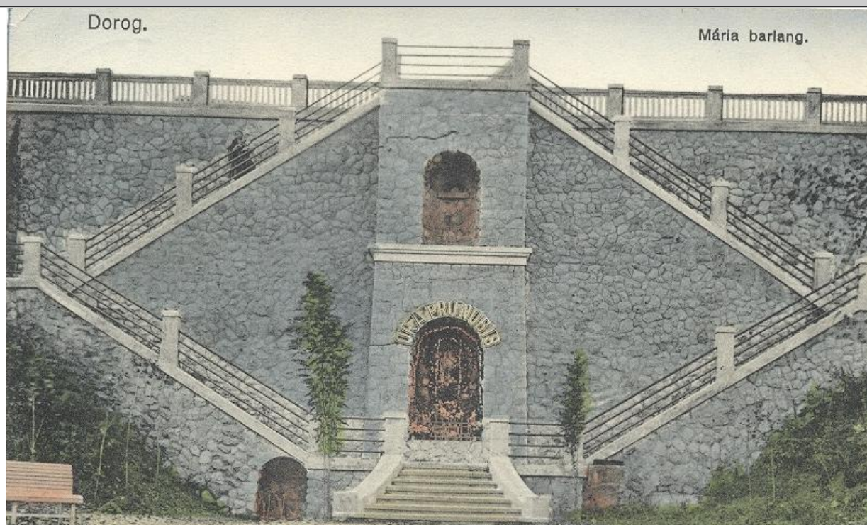
Fotók (építés-2012 között)
