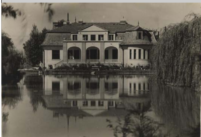
Fotók (építés-2012 között)
