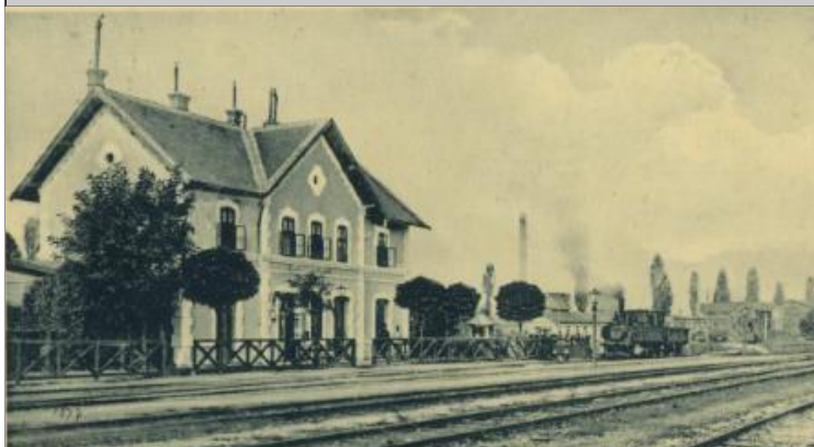
Fotók (építés-2012 között)
