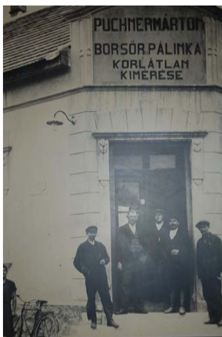
Fotók (építés-2012 között)
