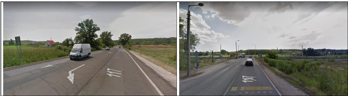
A 117. sz. út a gázfogadó bekötőútja előtti szakaszon és a 10. sz. főúti csatlakozása (Google maps)
