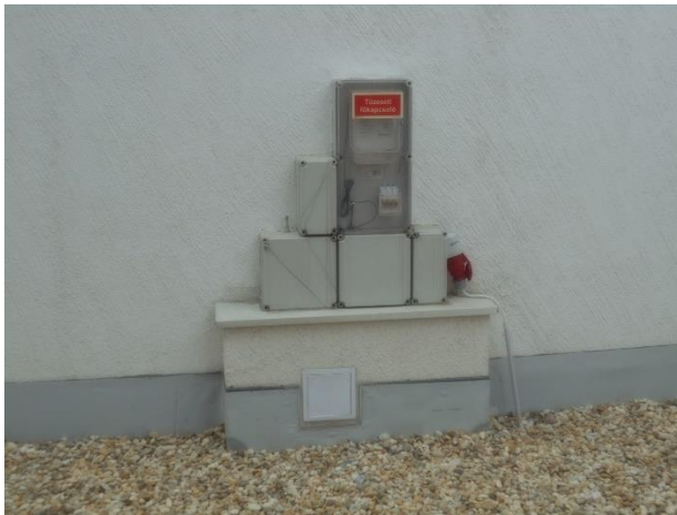
Elektromos mérőhely kialakítás
