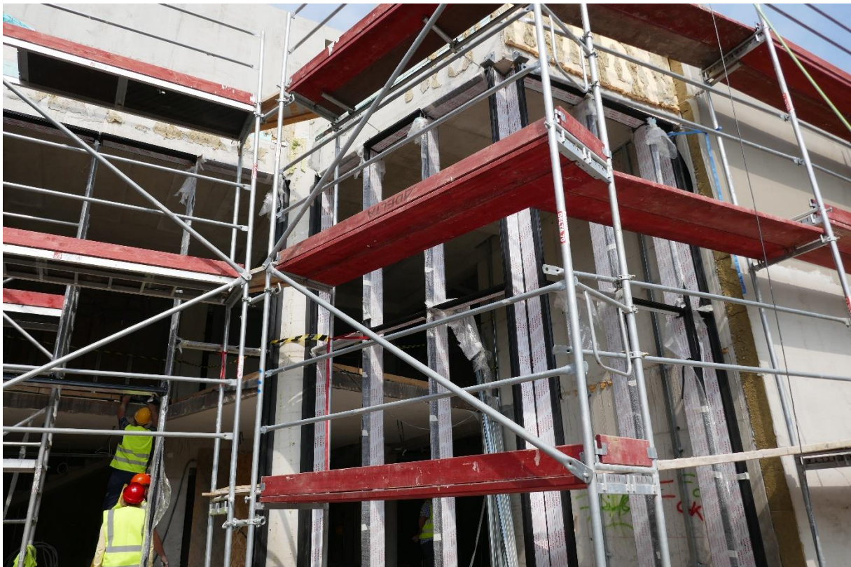
Homlokzati üvegfelület kialakítás
